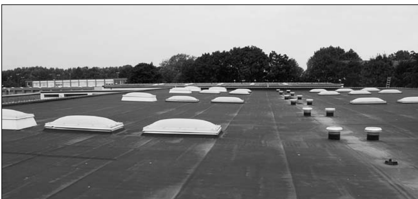
Nicht genutztes Dach (Abdichtung nach DIN 18531)
